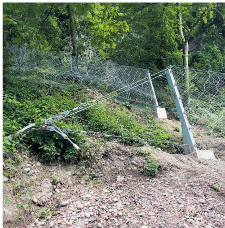
Là où le chemin est éloigné de la pente verticale, plus de 800 mètres de barrières ont été posés, empêchant les éboulis d'arriver jusqu'au chemin. Pour assurer les fixations au sol, des « clous » de 6 à 7 mètres de longueur s'enfoncent sous les semelles de béton. Photographies Blurette Staeger
