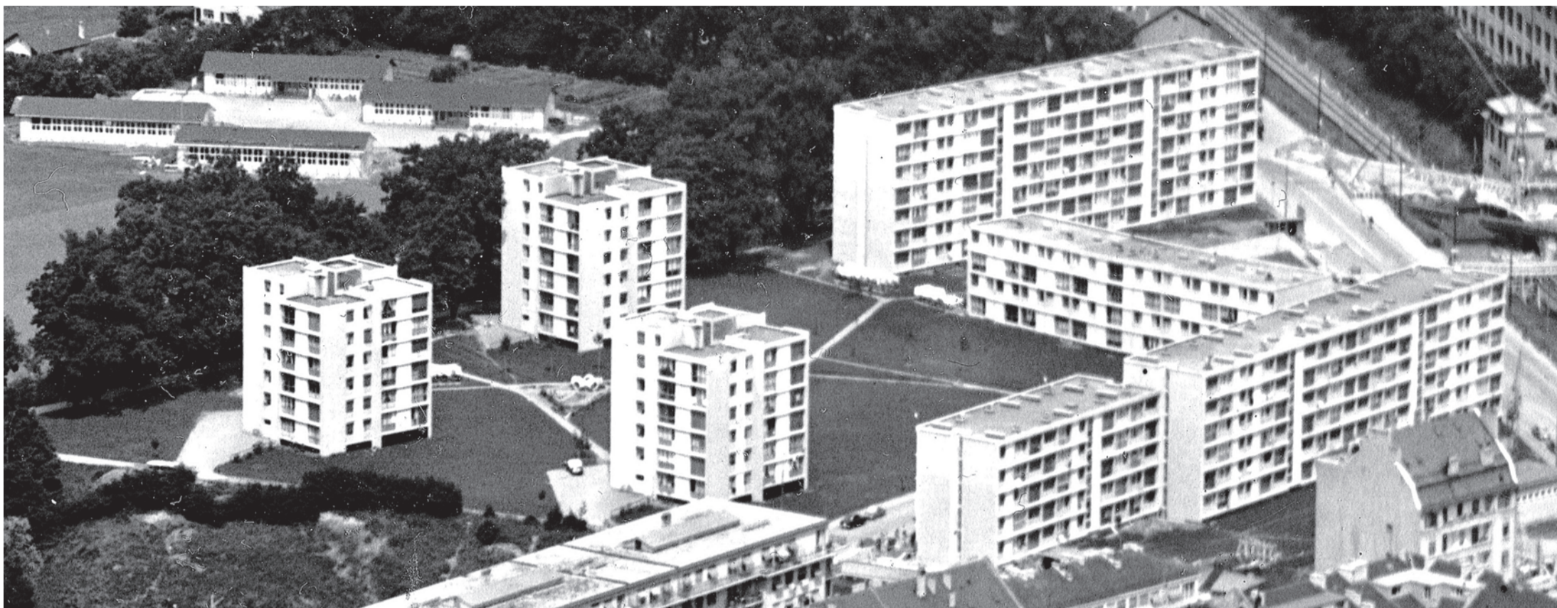
L'ensemble des immeubles du «Pré Cayla» autour de leur parc. Au fond à gauche, l'école primaire de Cayla. Photographie Belissart, 1957 (détail). Collection MQSJ
