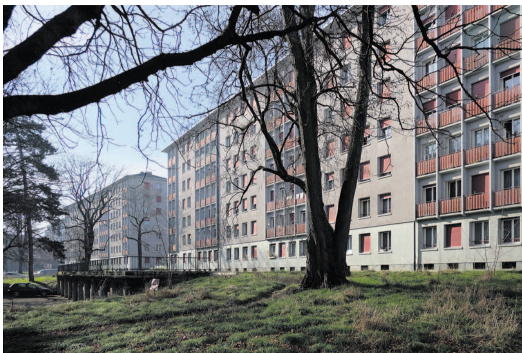
Les immeubles de la Fondation Jean-Dutoit, côté rue des Cèdres. Forum1203
