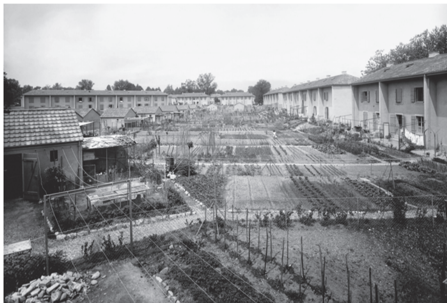
La coopérative de la SCHG dans son état d'origine de cité-jardin. Vue prise depuis l'avenue d'Aire en 1924. Photographie Frank Henri Jullien, BGE Collection MQSJ
