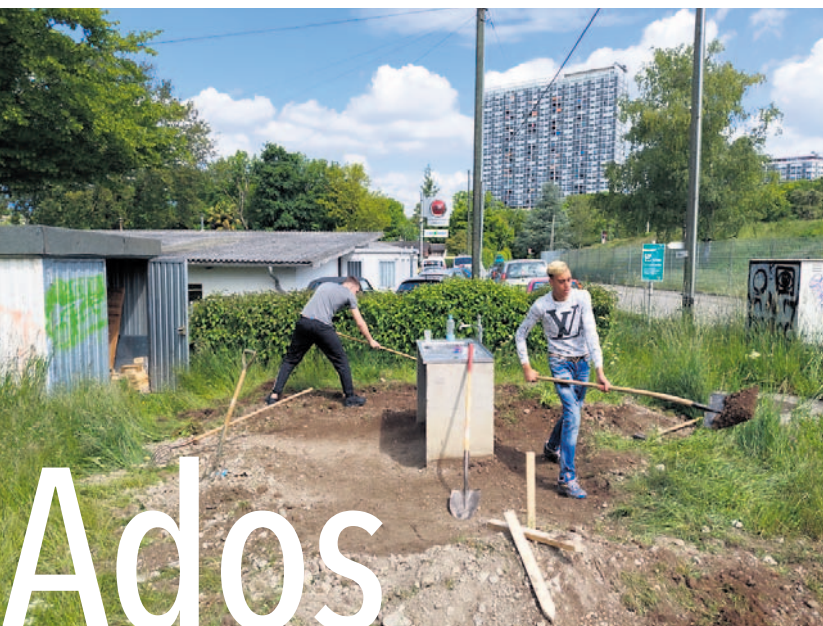
Construction d'un abri au terrain du centre aéré.
