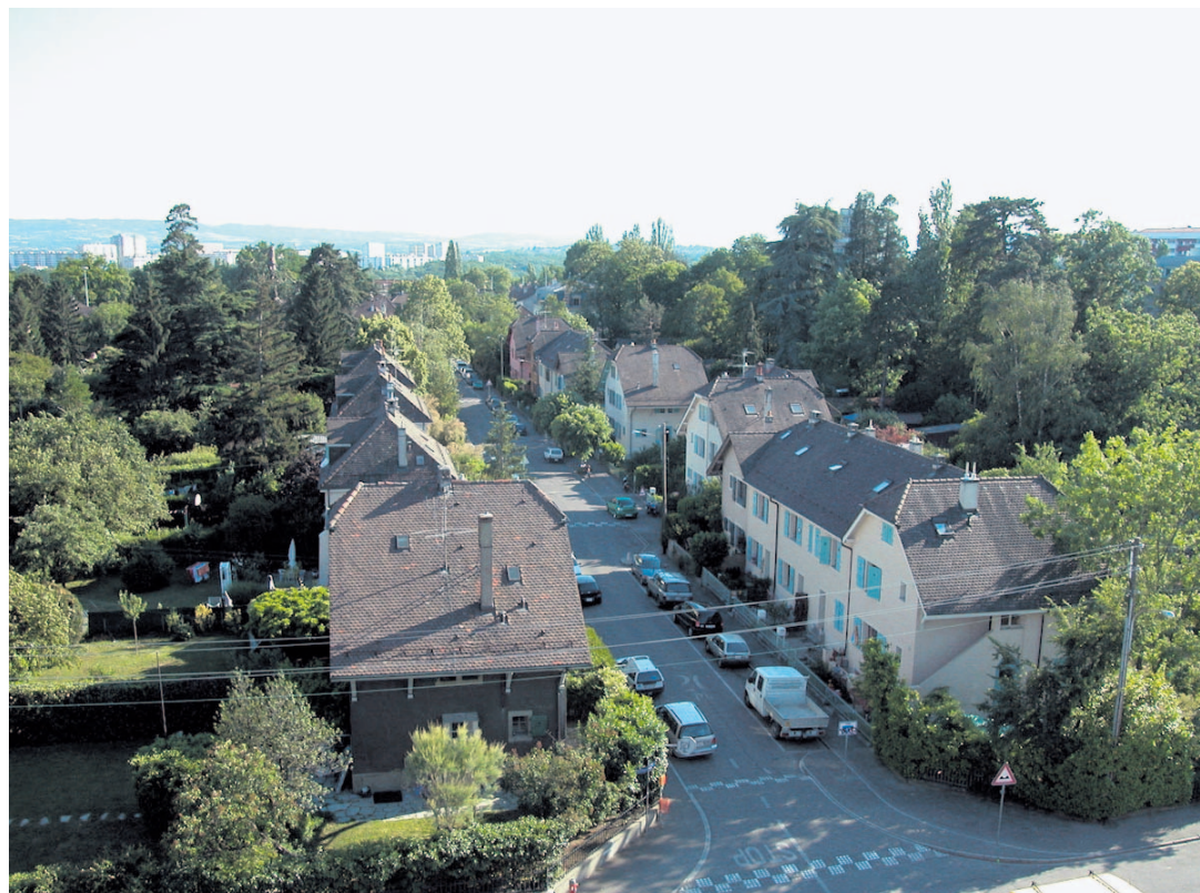
La cité-jardin Nouvel-Aire, réalisée par une fondation de l'État de Genève pour 70 logements, est encore présente dans son entier. Dans le cadre du Plan directeur de quartier (PDQ), douze maisons seront démolies entre les avenues de la Concorde et d'Aire en 2022.
