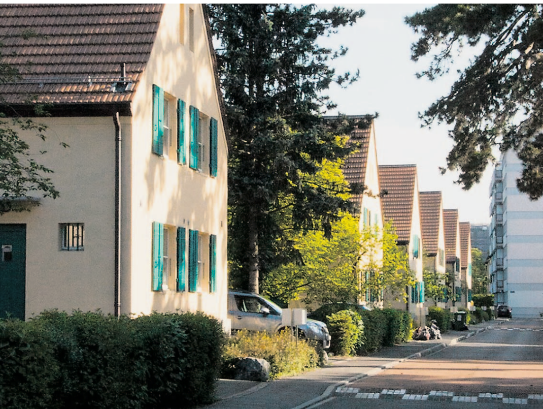
La cité-jardin d'Aire, réalisée par la Société coopérative d'habitation de Genève (SCHG). Après deux vagues de démolition-reconstruction dans les années 1960 et 1990, la SCHG a rénové ses dix maisons mitoyennes (24 logements) en 2009.
