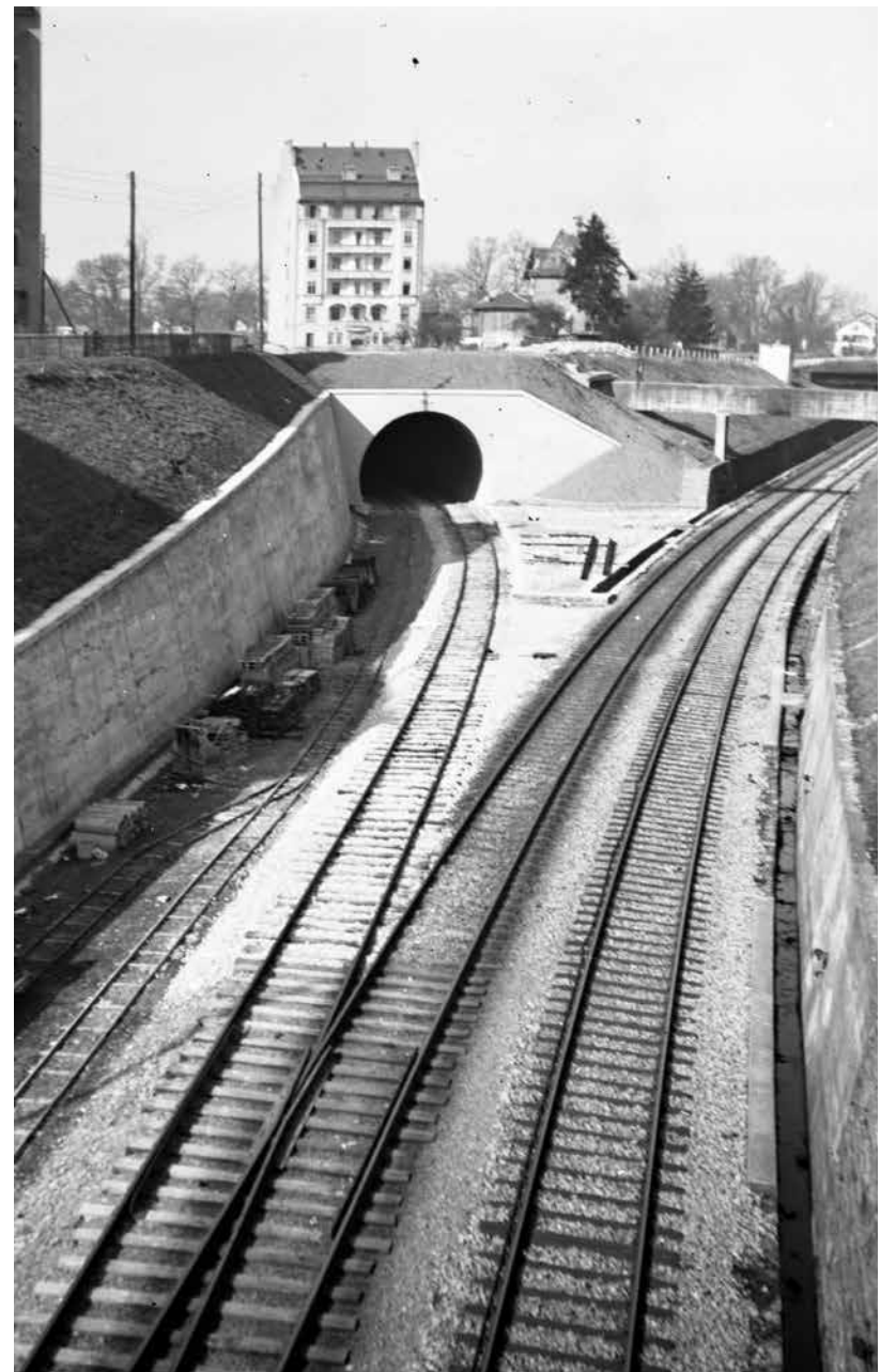
Tunnel vers la Praille à l'extrémité de la rue du Beulet (vers 1944) photo BGE-CIG
