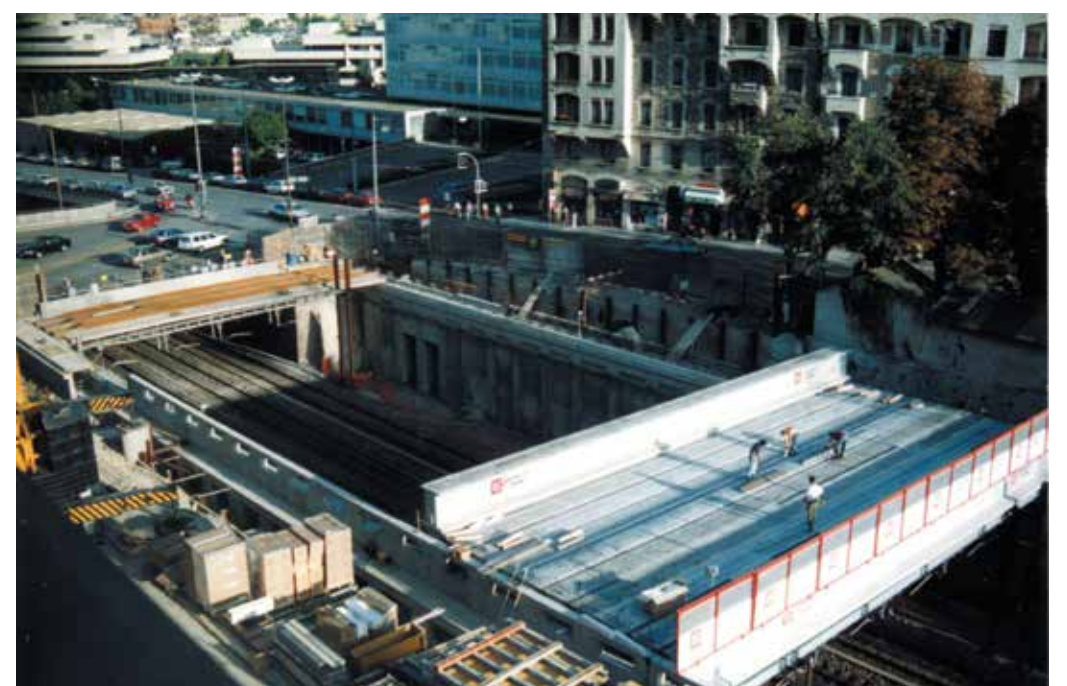
Premières poutres vers le pont des Délices. Photo Walter Trafelet.
