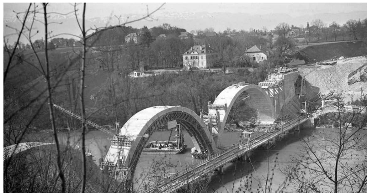
En 1945, les arches du viaduc en construction viennent s'appuyer contre le Nant-Cayla qui a été comblé. Photo Albert Matringe, Coll. J.-C. Curtet. Site Notre Histoire. Tous droits réservés.
